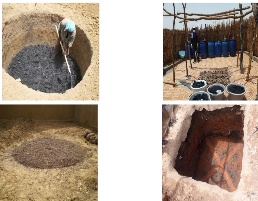
Fig 2 : Installation de puisard et méthode d'échantillonnage du sol dans le puisard
