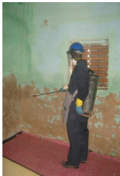
Figure 4 : Applicateur entrain d'asperger un mur intérieur
