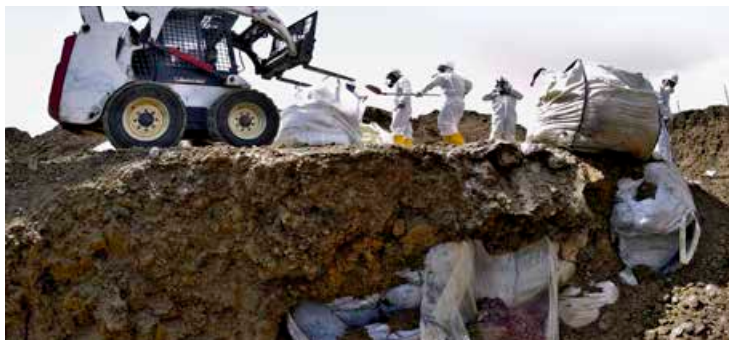
EXCAVATION DES PESTICIDES POP AU SITE D'ENFOUISSEMENT DES PESTICIDES À LAGLUJA, EN GÉORGIE. PHOTO DE VLADIMIR VALISHVILI.
