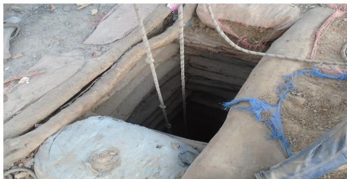
**Photo 9:** Corde servant de montée et de descente des ouvriers
