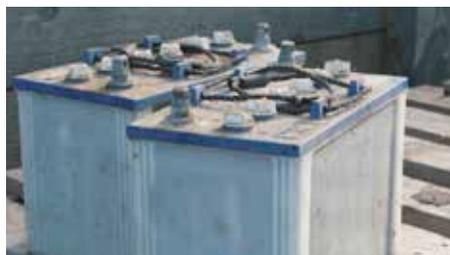
Fig. 46: Exemple de la gestion des batteries au plomb usagées incorrecte
