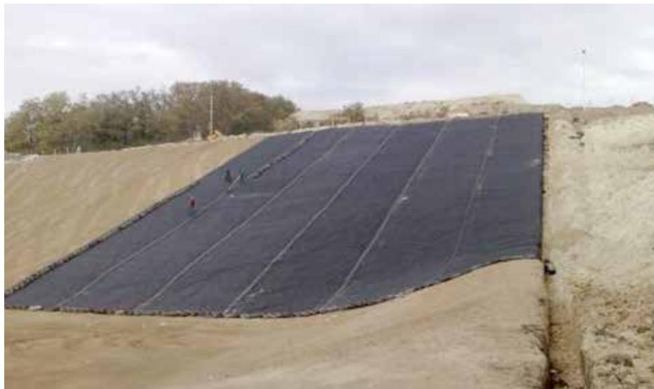
Fig. 35: Barrière artificielle utilisant l'isolation HDPE
