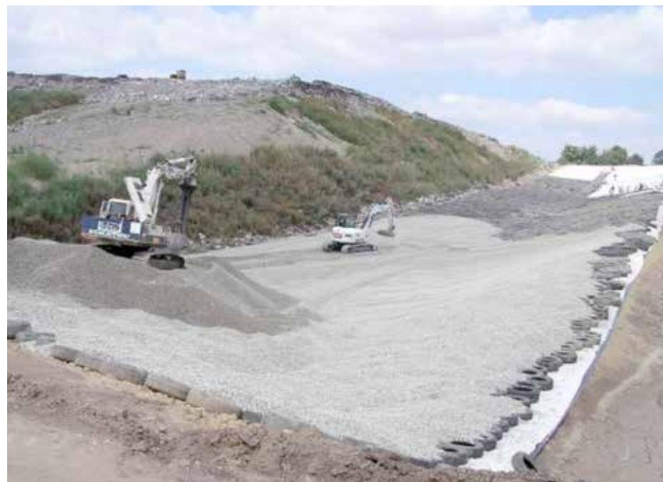
Fig. 34: Barrière géologique artificielle d'une décharge
