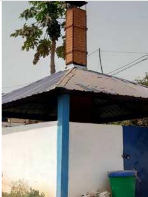
Photo 13 : Vue extérieure du modèle d'incinérateur type De Montfort amélioré par CDC dans un USP à Atakpamè
