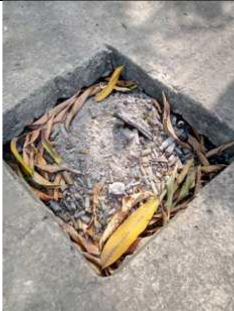
Photo 7 : Fosse à cendres remplie avec des résidus issus de la combustion incomplète des DASRI non triés au CHP Nostè
