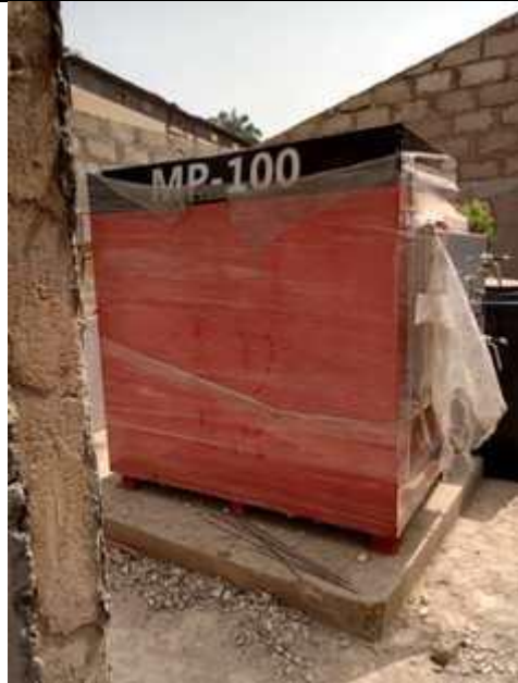
Photo 20 : Incinérateur conventionnel type MP 100 en cours d'installation au CHP Kpalimè
