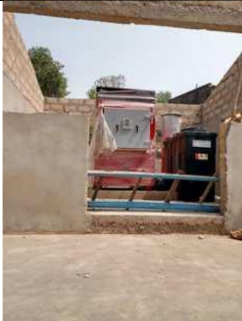
Photo 19 : Incinérateur conventionnel type MP 100 en cours d'installation au CHR Atakpamé
