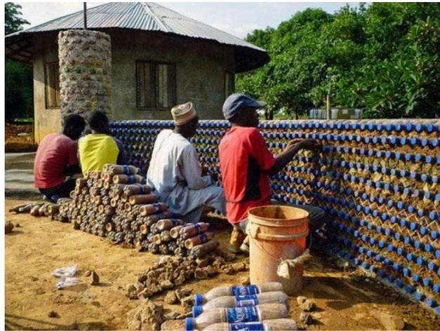
Figure 12 : construction d'une maison en Afrique à partir de bouteille plastiques
